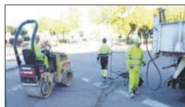
Operarios realizando trabajos de parchado de asfalto.
