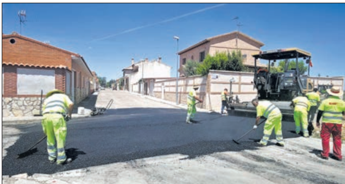
Operarios municipales realizando trabajos de reparación de baches en Rielves sobre el asfalto urbano.
